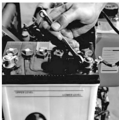
Подсоединение силового кабеля к минусовой клемме АКБ
